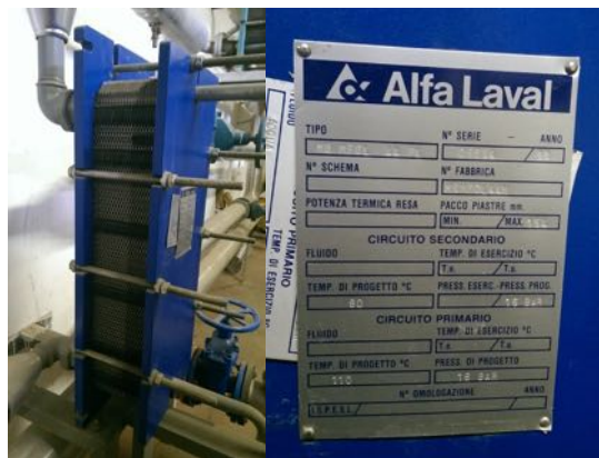
Fig. 16 Scambiatore termico
