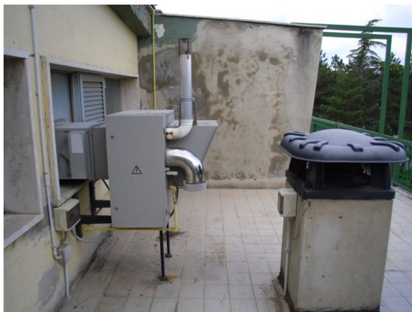
Fig. 18 Torrini di espulsione dell'aria dal locale piscine
