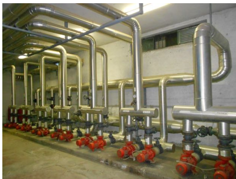
Fig.14 Impianto termico particolari del sistema di distribuzione
