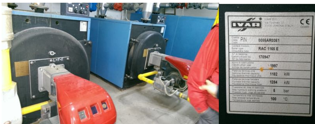
Fig. 13 Caldaie a basamento
