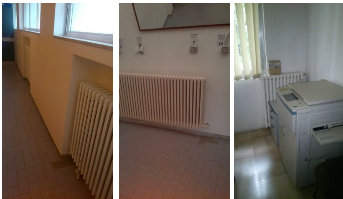
Fig.20 Radiatori in ghisa presso il complesso sportivo di parco Montereale
