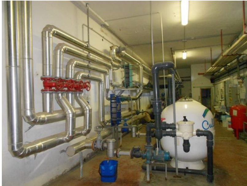
Fig. 15 Impianto termico: scambiatori, collettore, filtri e vasi di espansione
