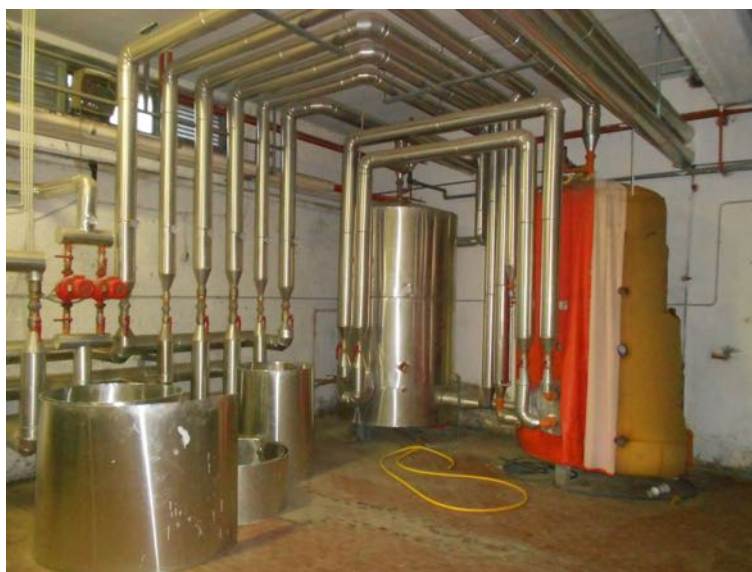
Fig.17 Bollitori per l'acqua calda sanitaria
