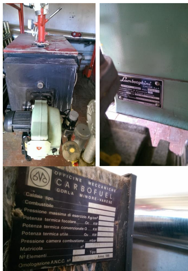
Fig.21 Dettaglio caldaia Carbofuel della palestra Caizzo e bruciatore Lamborghini
