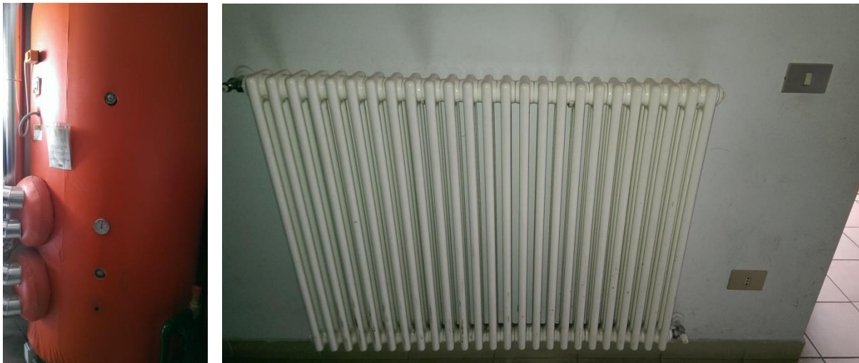
Fig.20 Bollitore da 2000 l e dettaglio di un radiatore presso l'impianto sportivo di via Roma
