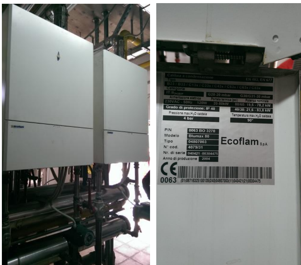
Fig.19 Dettaglio della centrale termica con caldaie a condensazione dell'impianto sportivo di via Roma
