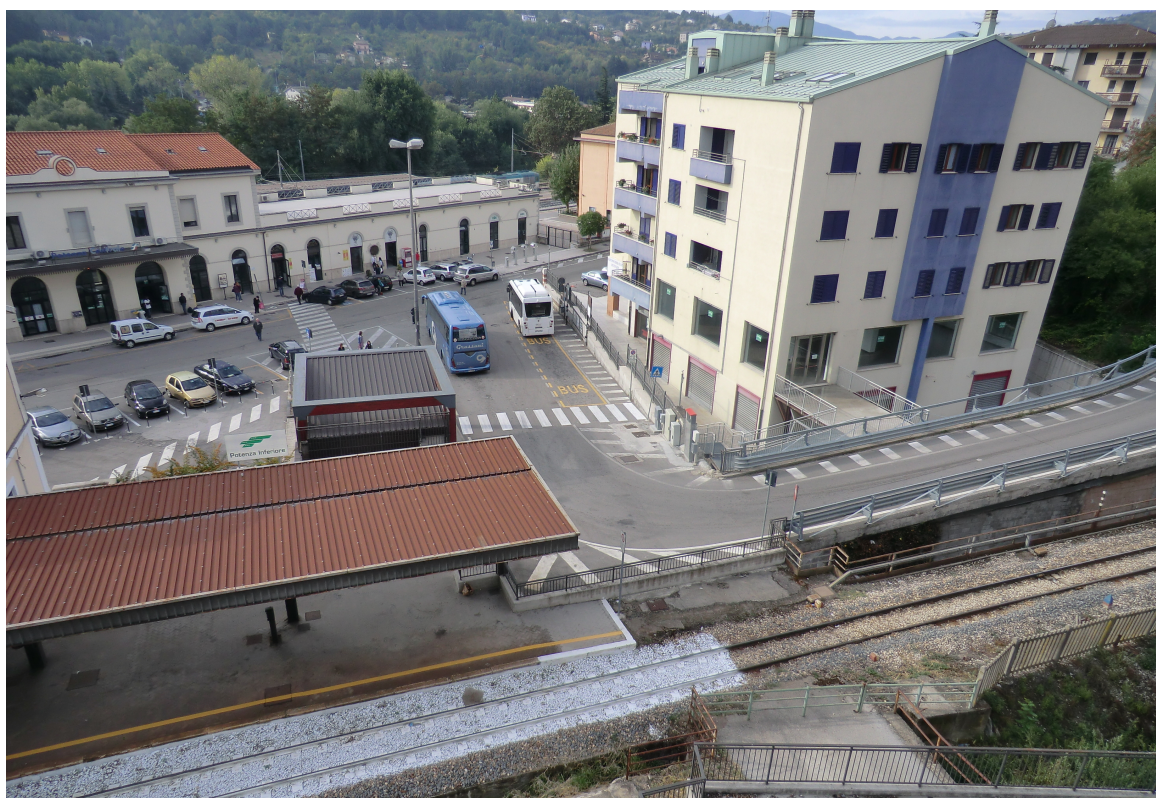
VISTE DEGLI ACCESSI AL PIAZZALE DELLA STAZIONE
