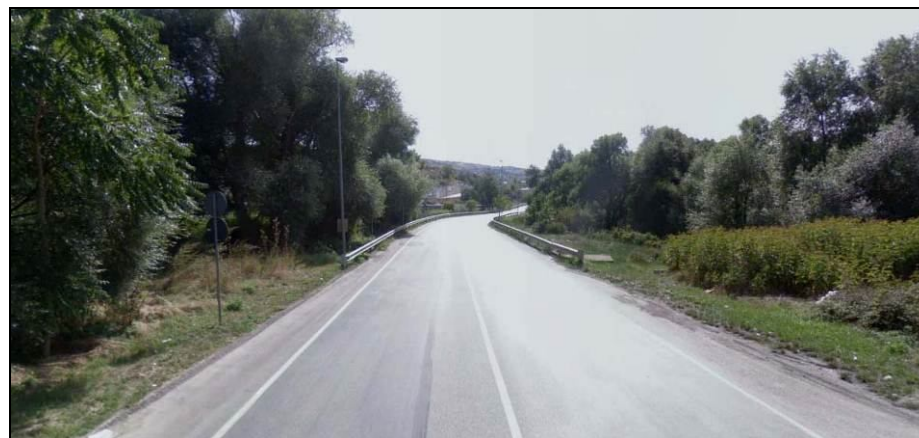
Foto 10 – Via della Fisica direzione sud
